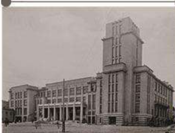
ДВОРЕЦ ТРУДА В ЛЕНГОРОДКЕ 1926-1930 ул. Гусева, 2а/5 М.Н. Кондратьев, А. Маркелов, Л.Ф. Эберг
