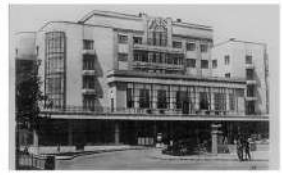
ГОСТИНИЦА «РОСТОВ» 1931-1934 пр. Буденновский, 59 Архитекторы: Л.Л. Эберг, И.Е. Черкескин, Х.Х. Чалушьян
